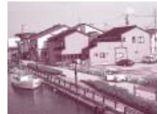
写真9：壊され分断された町並
